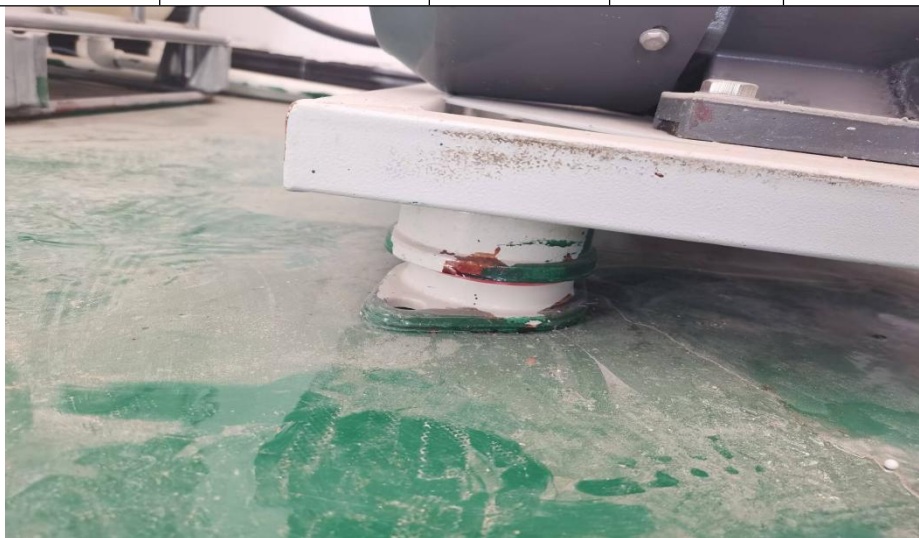
图6 设备基础减震
