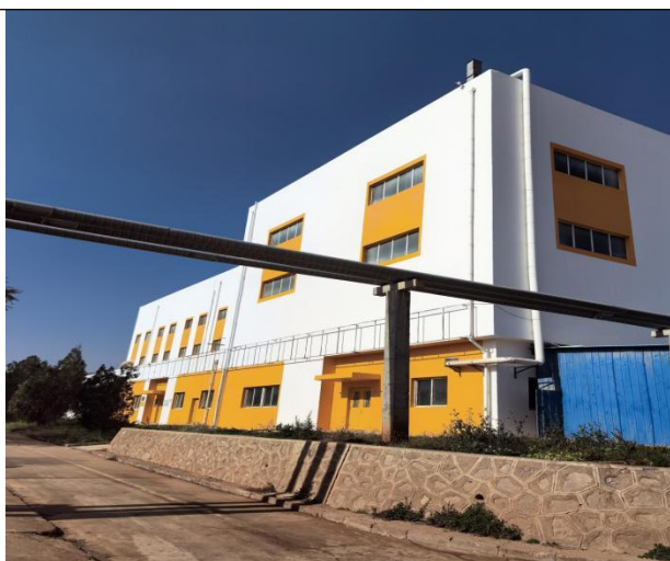
危险废物储存车间
